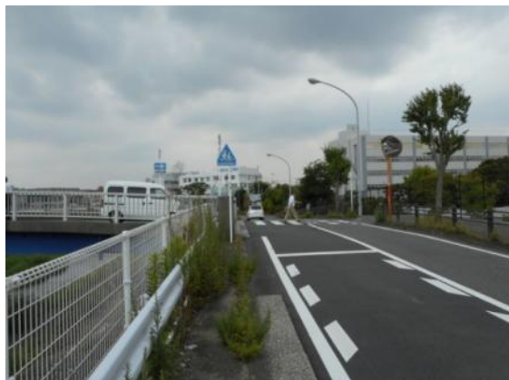
駒立橋・吉田町 292 番地付近（6月22日 撮影）
