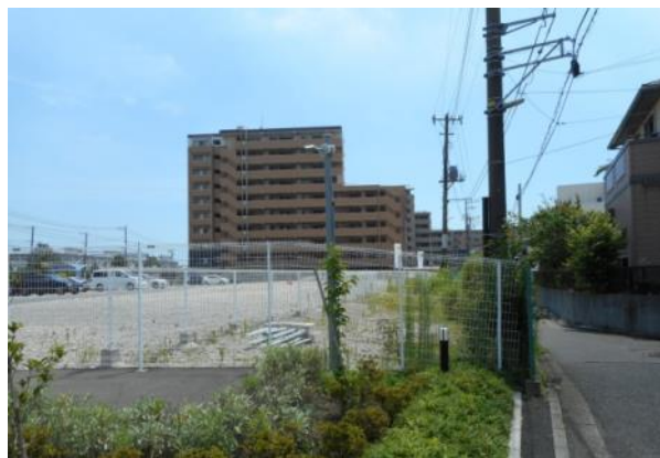
戸塚町 244 付近マンション計画現場<150720 撮影>
