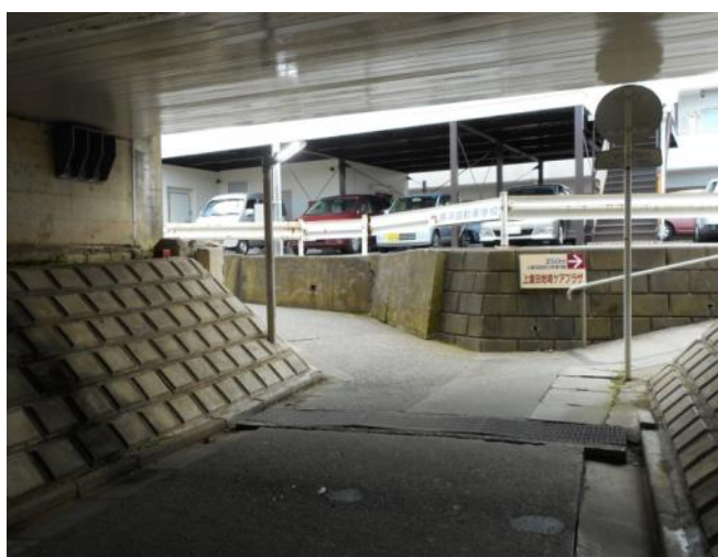
隧道西側出口付近の状況 <150719 撮影>
