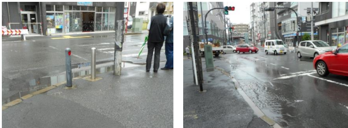
矢部町3及び4番地付近交差点の路面凸凹・水たまりの状況 <150717撮影>
