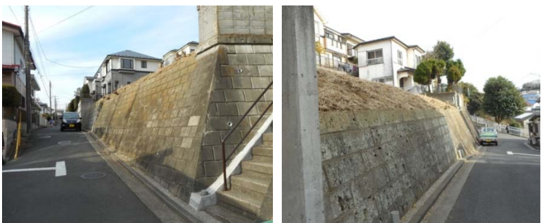
平戸町宅地・空き地の刈取り実施後の状況（1月21日撮影）
