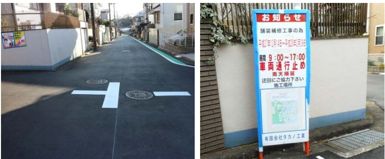
道路舗装の改修工事後の状況 (2016年2月18日撮影)
