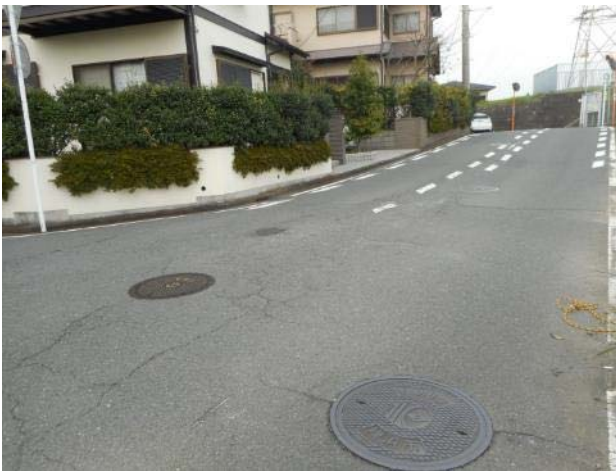
上矢部町 2449 付近 市道路面舗装の凸凹状況（10 月 21 日 撮影）
