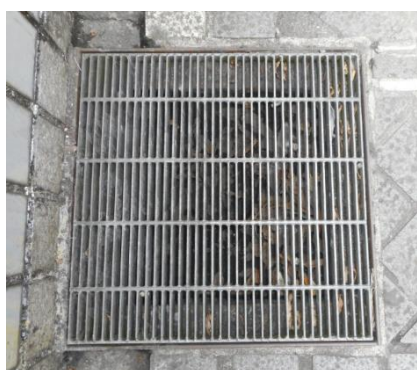
雨水排水溝の泥詰まりの状況（撮影 2019年2月13日）
