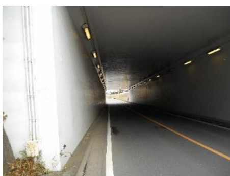
大坂台立体交差
