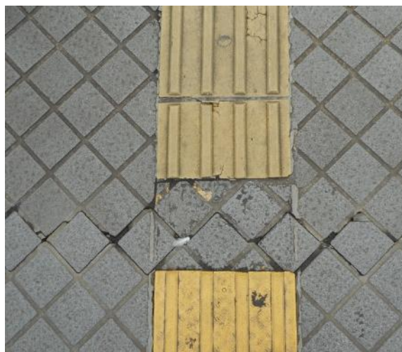
戸塚東口デッキ 点字ブロック一部欠損の状況（撮影 10 月 18 日）
