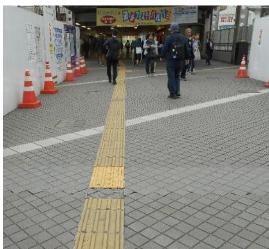
戸塚東口デッキ 点字ブロック一部欠損の状況（撮影 10 月 18 日）
