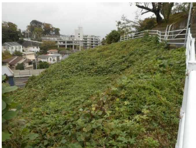
戸塚町 3626 付近の斜面地の状況
